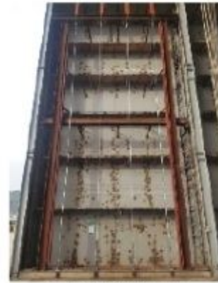
일방향 케이블 설치
