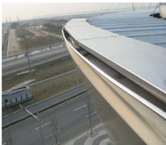
기존 시공법에 의한 COPING 제작설치 세그먼트1
